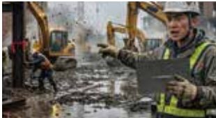
■防水、防塵現場&工程管理
